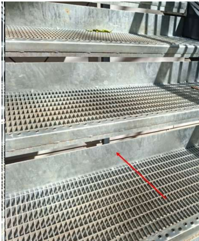
Gitterroststufen mit Setzblech/ als Abdeckung
